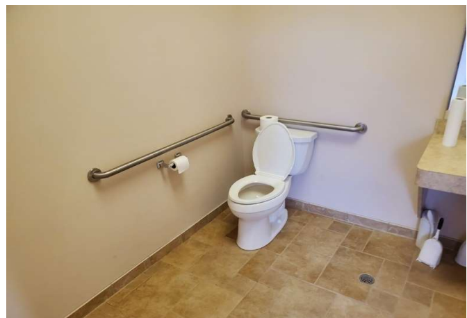
ADA accessible toilet area
